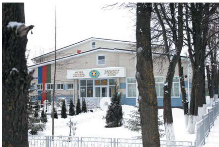
В 2019 году в здании музея «Дружба народов» прошел капитальный ремонт
