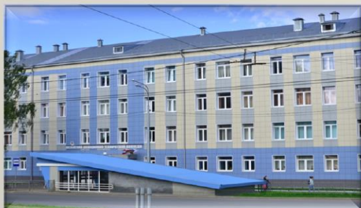
Учебное здание №1 г. Казань, ул. Копылова, д. 2 б
